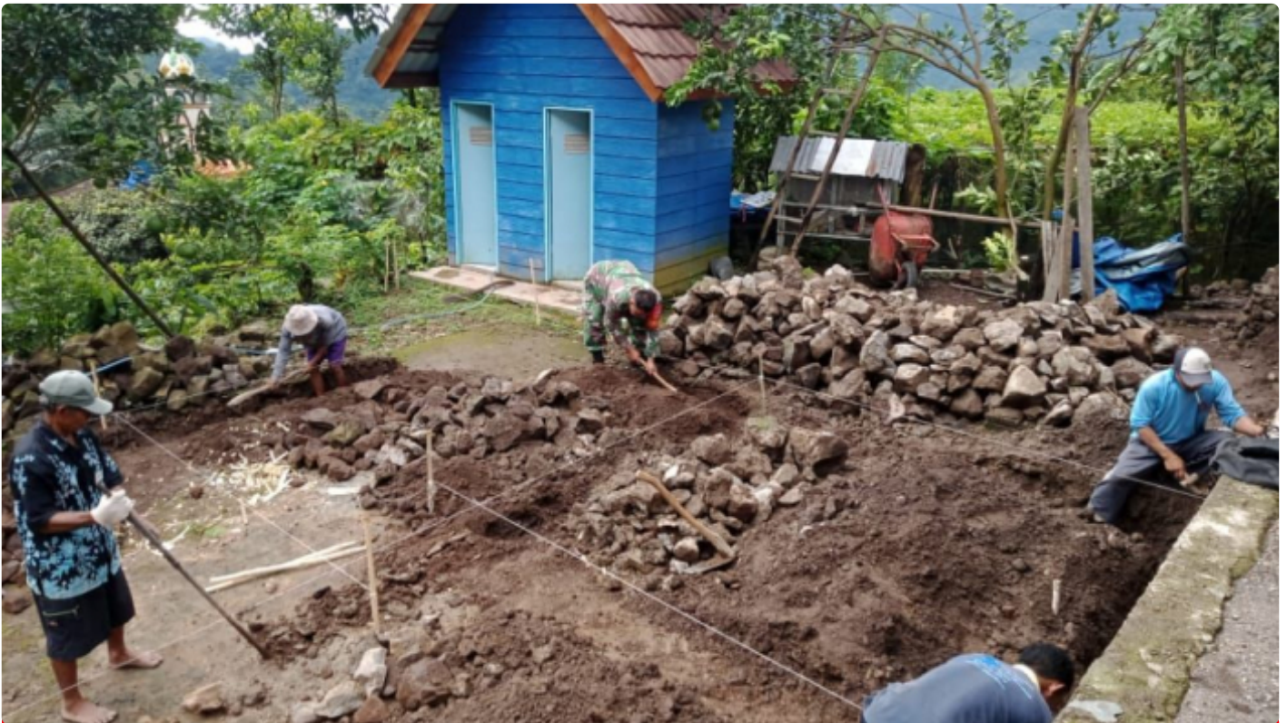
Babinsa Koptu Nono anggota Koramil 08/Keling bantu pembangunan RTLH warga binaan
